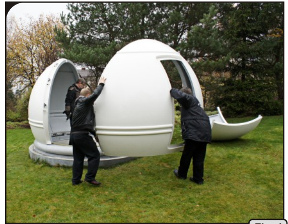
Budowa kopuły na wylewce w ogrodzie
