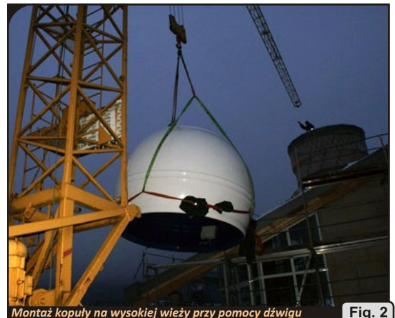
Montaż kopuły na wysokiej wieży przy pomocy dźwigu
