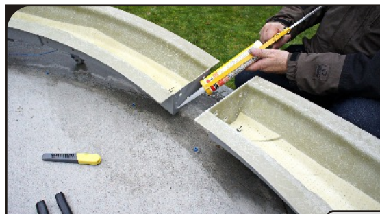
Uszczelnienie krawędzi pierścienia podstawy
