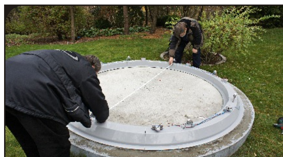
Pomiar średnicy wewnętrznej pierścienia podstawy
