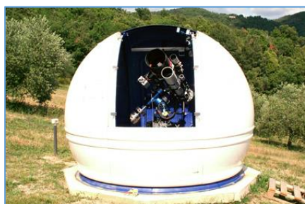
Fot. 70. Kopuła na betonowej wylewce
