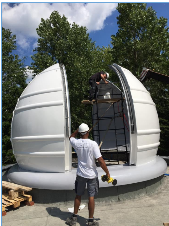
Fot. 92. Budowa obserwatorium astronomicznego w Koszalinie
