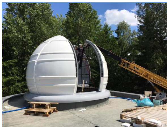
Fot. 68. Ekipa montażowa kopuły astronomicznej
